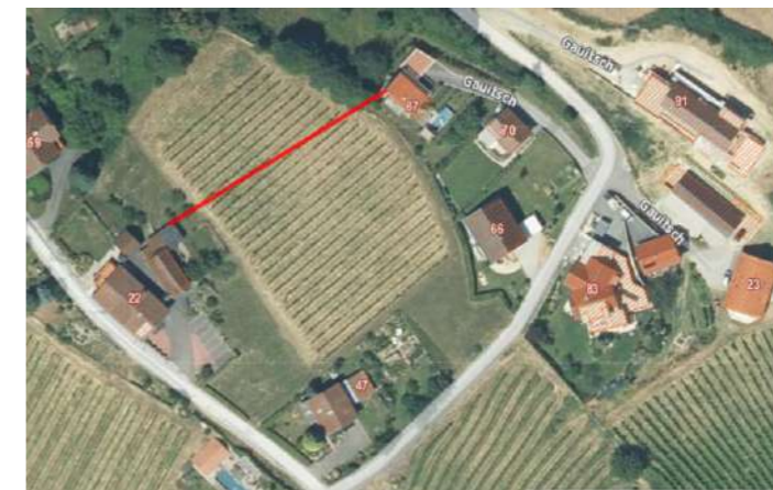
Abbildung 150: Grenze einer möglichen „Auffüllung“
