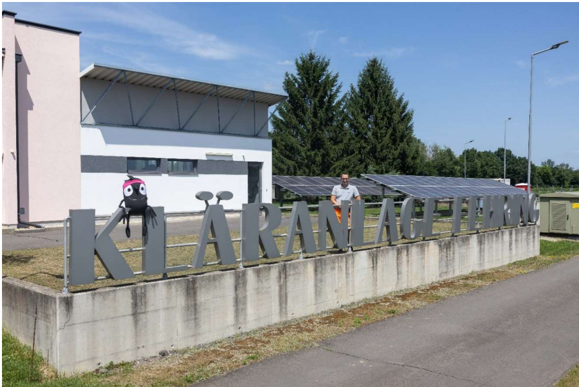
Daniel Fink und Edgar begutachten die PV-Anlage bei der Kläranlage Fehring
