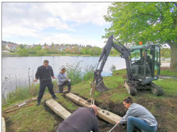
Fundament für Wach-Container wird gesetzt
