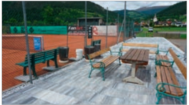
Erneuerung der Tennisplätze 1 und 2 sowie Gestaltung des Vorplatzes mit Pflastersteinen.
