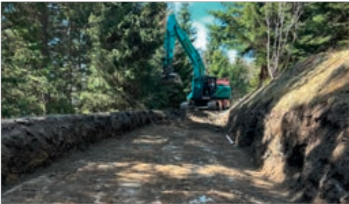
Hocheggerstraße - teilweise Erneuerung des Unterbaues und Aufbringung einer neuen Asphalttschicht.
