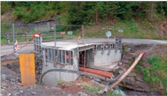
Generalsanierung der Palsbrücke in der Salchau mit Verbreiterung der Fahrbahn.
