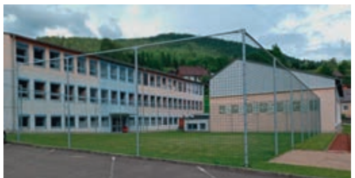
Errichtung einer Ballfanganlage vor der Mittelschule
