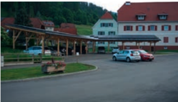
Fertigstellung der Carports Schöttlbach und Anbringung einer Photovoltaikanlage mit Einspeisung in das Seniorenwohnheim.
