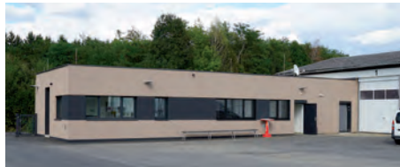
Zubau Bauhof Fehring Foto: Stadtgemeinde Fehring
